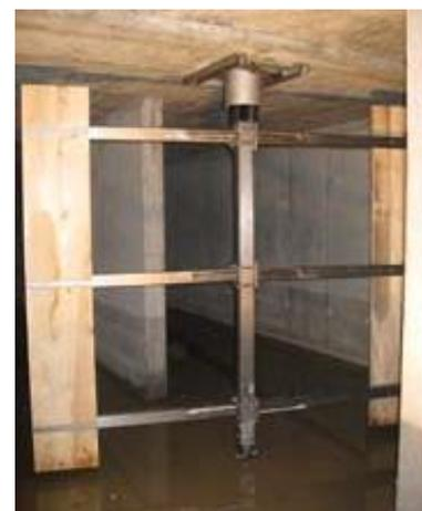
Der Antrieb kann auch seitlich versetzt montiert werden. Das rostfreie Montagegehäuse wird hierfür versenkt auf die Deckenschalung befestigt. Platzsparende und einfache Installation.
